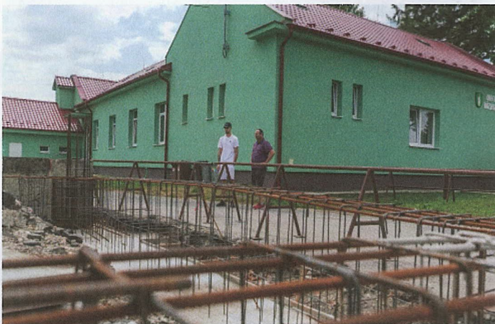
A községháza mellett zajlik az új fedett szabadtéri színpad építése. A komplett tetőszervezete szeptemberben készül el, és a lámpákat is akkor helyezik el.
