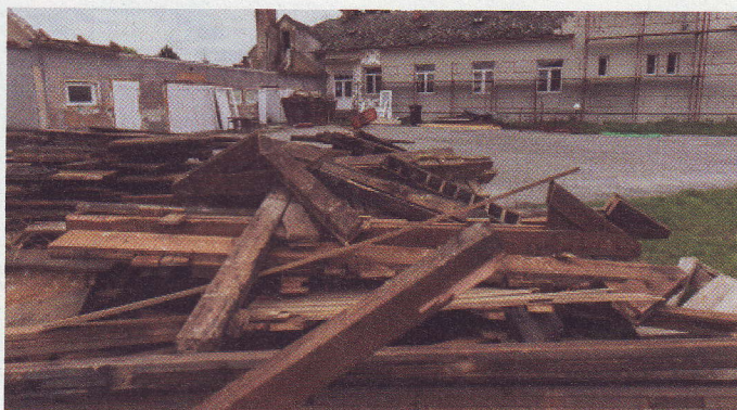
Budova obecného úradu pred rekonštrukciou. Zadná časť bola v dezolátnom stave.
