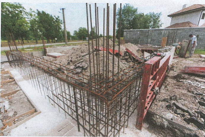
Pri obecnom úrade finišuje výstavba nového krytého amfiteátra, ktorý bude úplne dokončený v septembri. Den Svätého Štefana plánujú usporiadať už na novom javisku.
