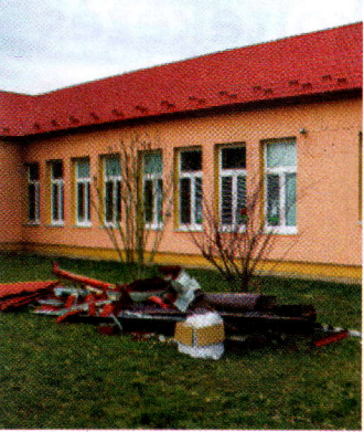
Az épület a tetőcsere után.....
